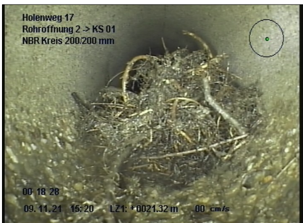
Foto: 6_15B 20.6m, Lose Ablagerungen, von 04 bis 08 Uhr, Anfang
