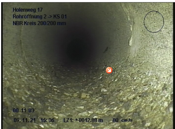
Foto: 6_12A 12.8m, Muffe, leicht ausgebrochen, bei 05 Uhr
