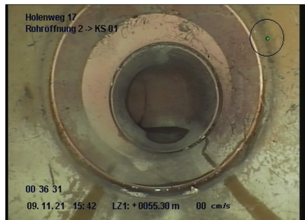
Foto: 6_31A 55.3m, Querschnittsverkleinerung, 150 mm
