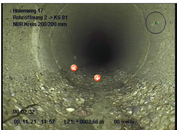
Foto: 6_6A 2.6m, Muffe, leicht ausgebrochen, von 05 bis 08 Uhr
