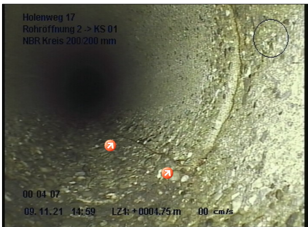
Foto: 6_7A 4.7m, Muffe, leicht Wurzeleinwuchs, bei 05 Uhr
