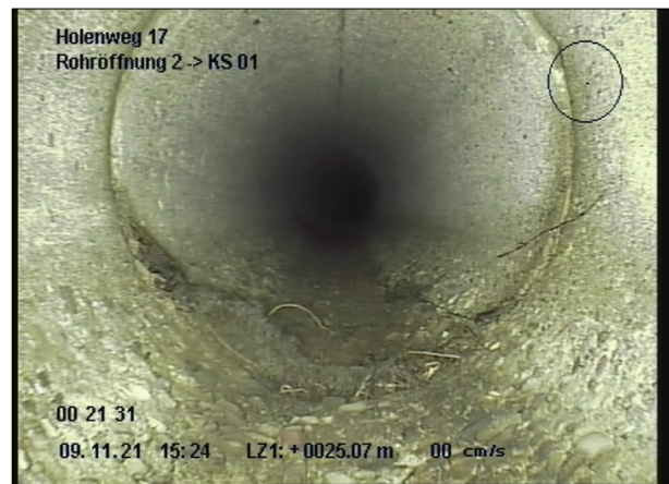
Foto: 6_18A 25m, Muffe, leicht Wurzeleinwuchs, von 05 bis 08 Uhr
