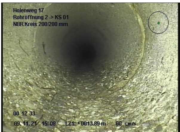
Foto: 6_13A 13.8m, Muffe, leicht ausgebrochen, von 04 bis 06 Uhr
