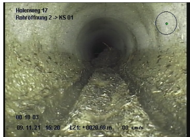
Foto: 6_15A 20.6m, Lose Ablagerungen, von 04 bis 08 Uhr, Anfang
