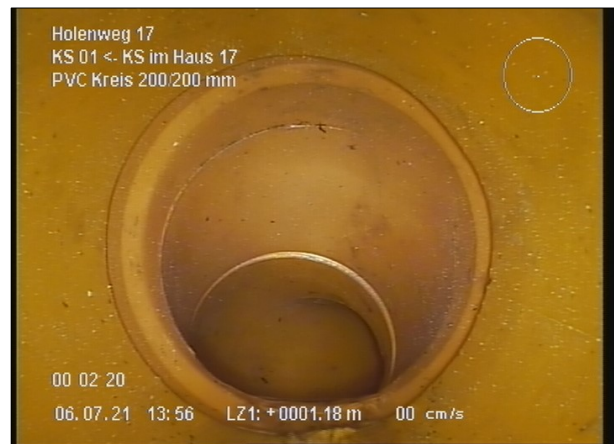
Foto: 1_5A 1.1m, Übergang in Horizontale / Bogen
