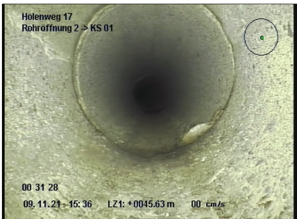
Foto: 6_27A 45.6m, Muffe, harte Ablagerungen, leicht, von 04 bis 05 Uhr / leichter Wuezeleinwuchs
