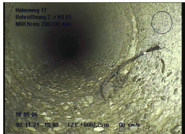
Foto: 6_8A 7.7m, Muffe, leicht Wurzeleinwuchs, von 04 bis 05 Uhr
