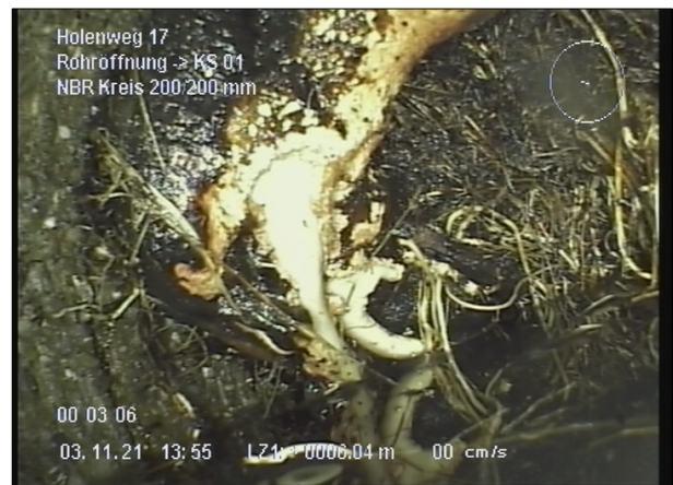
Foto: 3_4B 6m, Wurzeleinwuchs, stark, von 12 bis 12 Uhr
