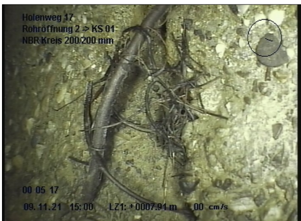
Foto: 6_8B 7.7m, Muffe, leicht Wurzeleinwuchs, von 04 bis 05 Uhr
