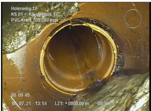
Foto: 1_3A 0m, Muffe, leicht Wurzeinwuchs, von 12 bis 05 Uhr
