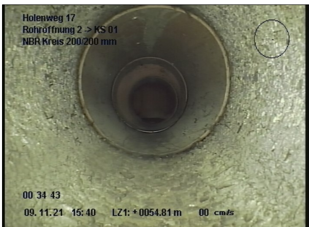
Foto: 6_30A 54.8m, Rohrmaterialwechsel, PVC
