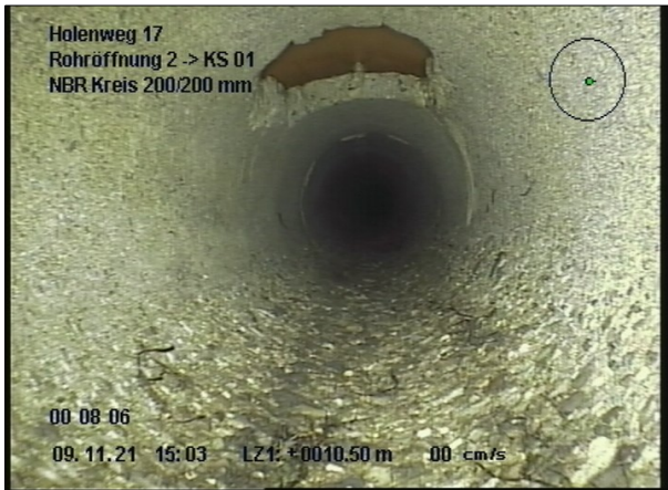
Foto: 6_10A 10.5m, Reparaturstelle von 11 bis 01 Uhr
