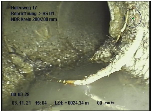
Foto: 4_4A 24.3m, Bogen nach rechts / ausgebrochen
