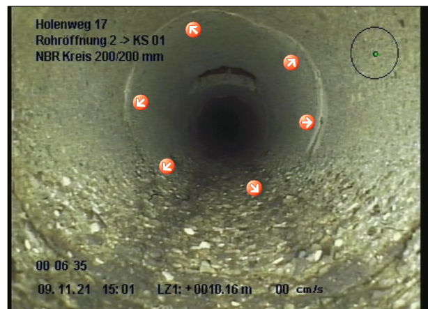
Foto: 6_9A 10.1m, Radialriss von 12 bis 12 Uhr
