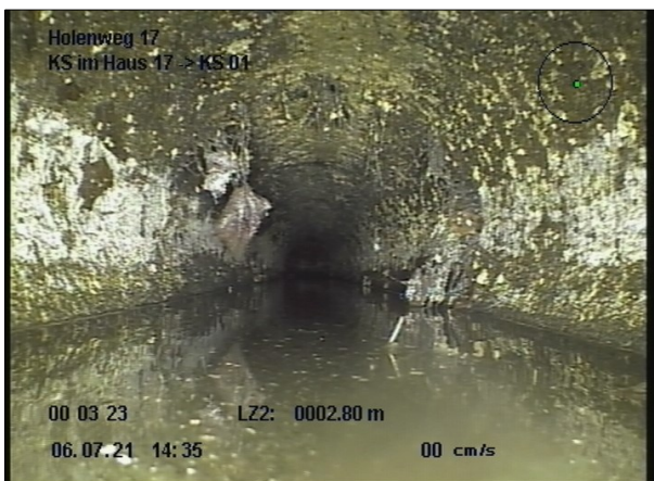
Foto: 2_7A 2.8m, Muffe, leicht Wurzeleinwuchs, von 10 bis 04 Uhr
