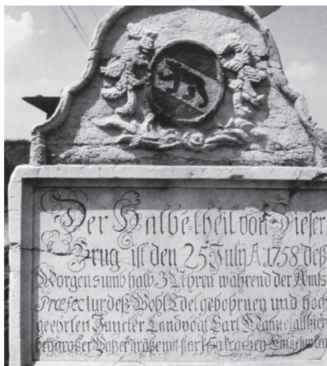
Am 25. Juli 1758 richtete die stark angelaufene Aare grossen Schaden an und riss den halben Teil der Brücke mit.
